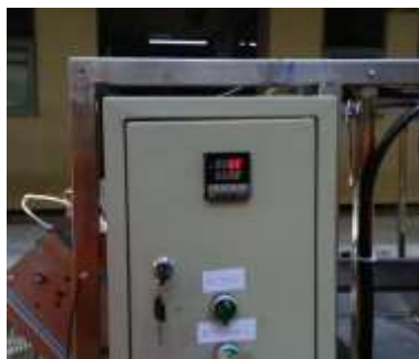
Gambar 4.4 Uji Elemen Pemanas pada bak penampungan air
